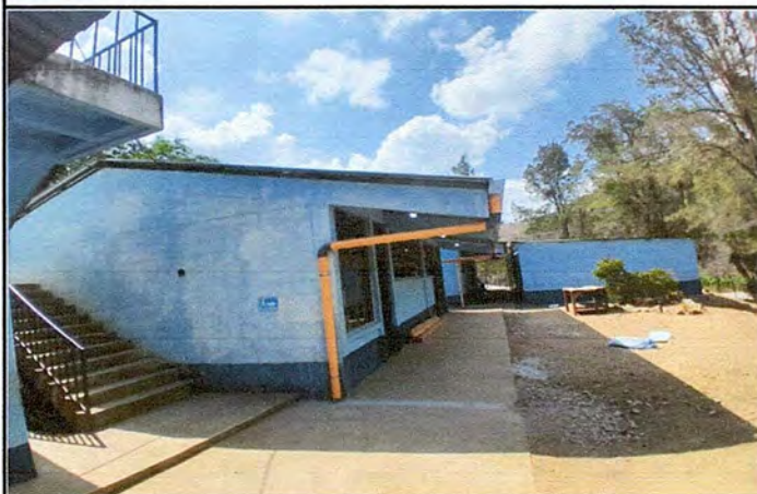
Foto 3: Mejoramiento del techo lateral finalizado
