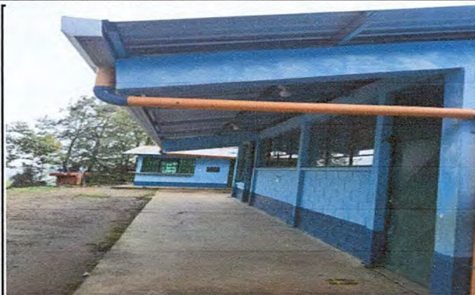
Foto 1: Mejoramiento del techo frontal finalizado
